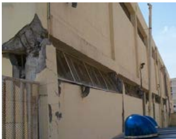
Fig.3.10. Stâlpi scurți, Algeria, 2003 (stânga), Cedarea stâlpului datorită zidăriei parțiale (dreapta)
