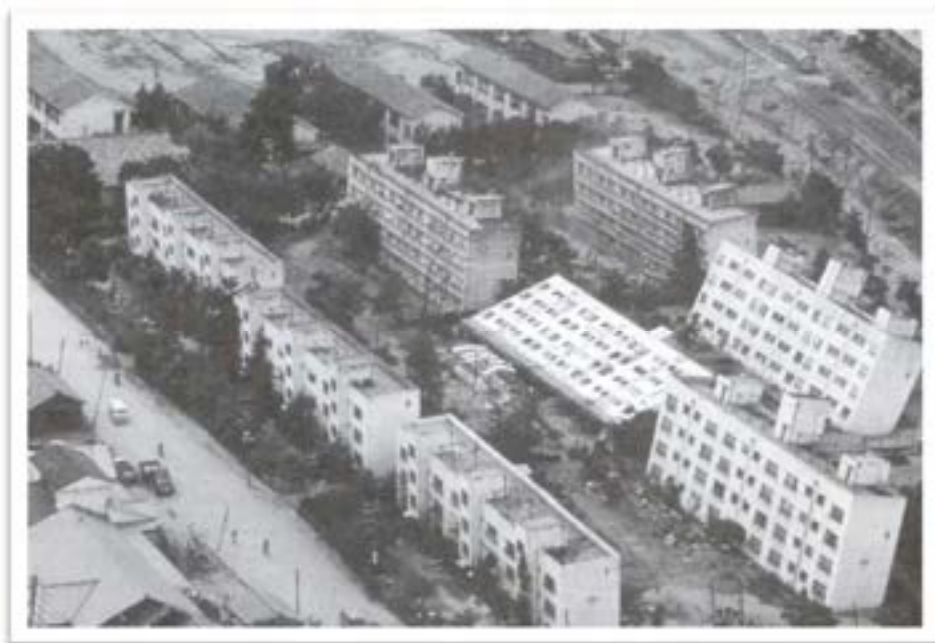
Fig.3.19. Lichefierea solului sub fundație datorită seismului și răsturnarea unor blocuri, Niigata, Japonia 16 iunie 1964, cutremur 7,6 Richter
