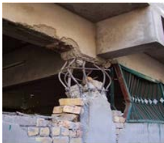
Fig.3.10. Stâlpi scurți, Algeria, 2003 (stânga), Cedarea stâlpului datorită zidăriei parțiale (dreapta)
